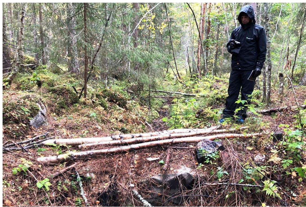
Ett dike har lagts igen med en fiberduk och några massavedsbitar. Skidån, Jämtland.
