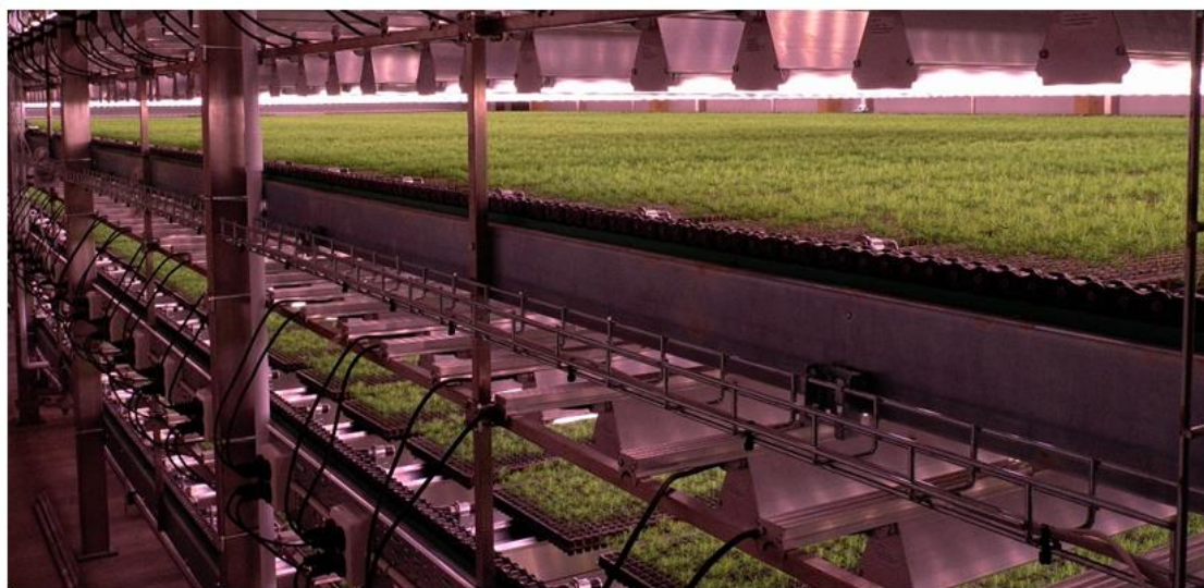
Med odlingskammare blir plantproduktionen jämnare och bättre. Odling kan ske energieffektivt året runt. Friggessunds plantskola, Hälsingland.
